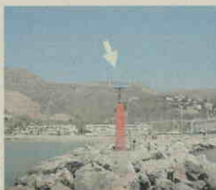
Abalisament amb plaques solars
