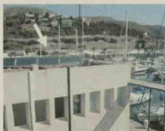
Plaques solars a edifici de capitania
