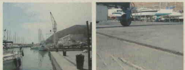
Xarxa perimetral a l'escar interceptora d'aigües pluvials
