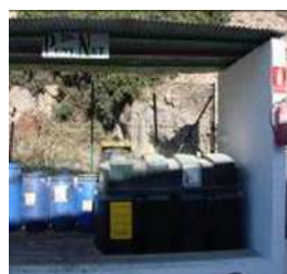
Extintors al Punt Net
