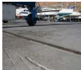
Xarxa perimetral a l'escar interceptora d'aigües pluvials
